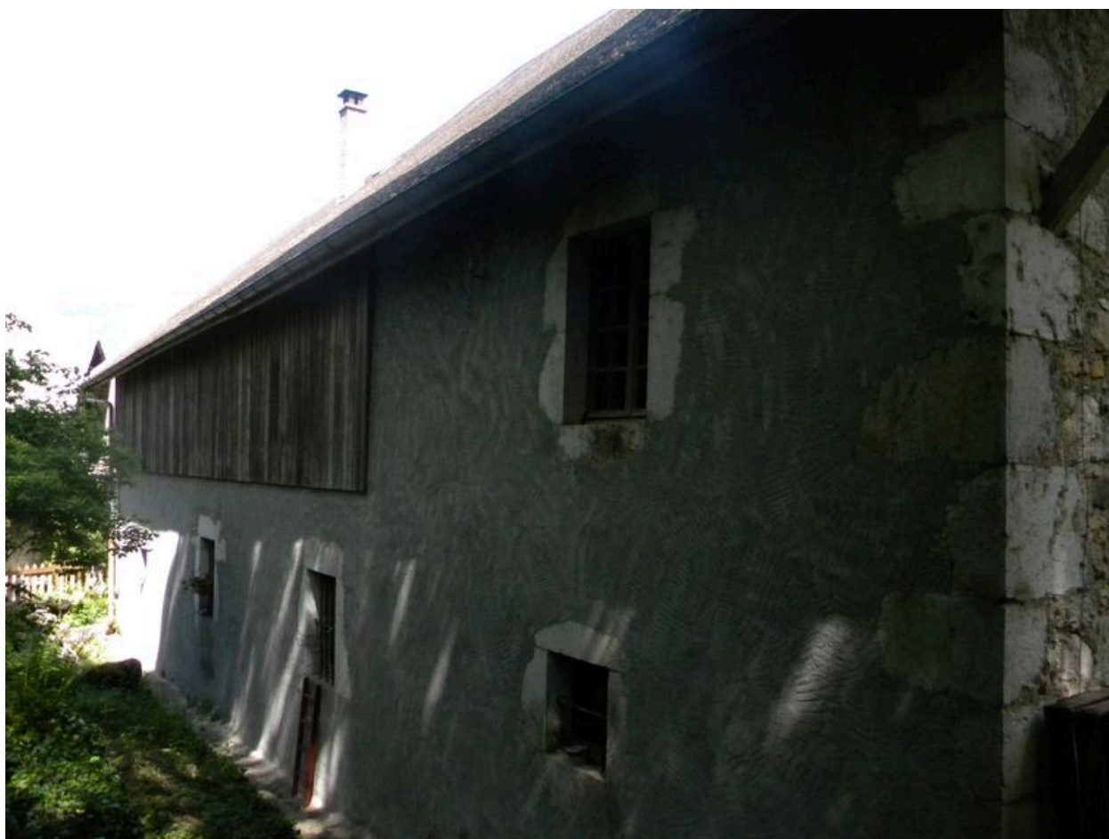
Vue de la façade ouest depuis le sud.
