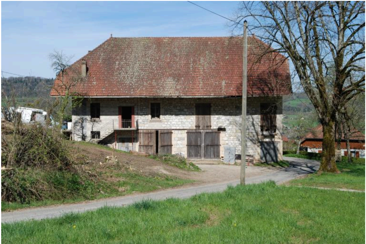
B9 2350, 2351, 2353, grange-étale. Vue d'ensemble de face.
