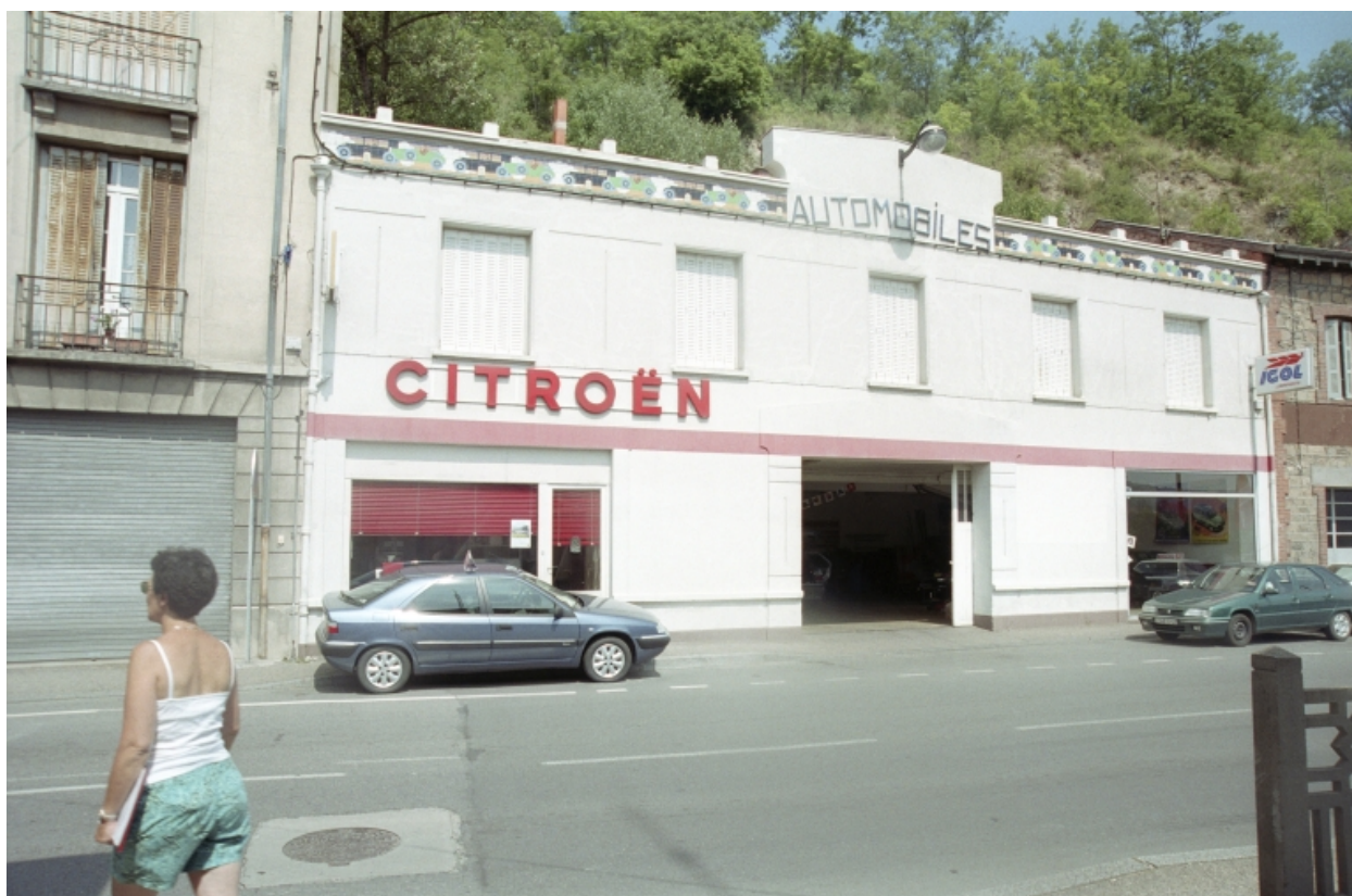
Boën, îlot 17, Lyon (rue de) 75. Vue générale de la façade sur rue.
