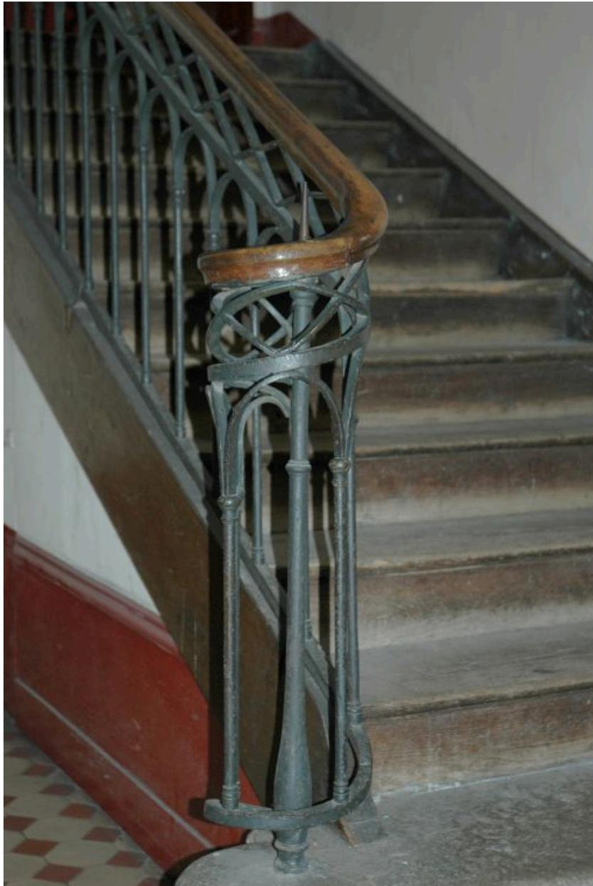
Rampe d'escalier en fer forgé à départ enroulé.
