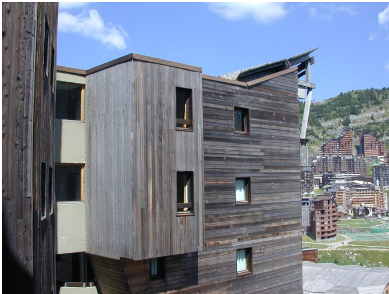
Vue sud-ouest du pignon sud, partie supérieure
