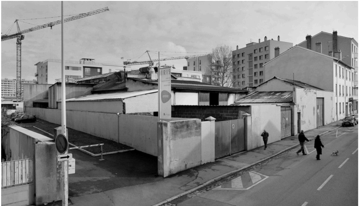
Vue générale de la fonderie Bordery
