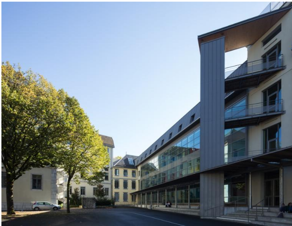
Aile Marcoz côté cour, nouvelle façade et accès ascenseur.
