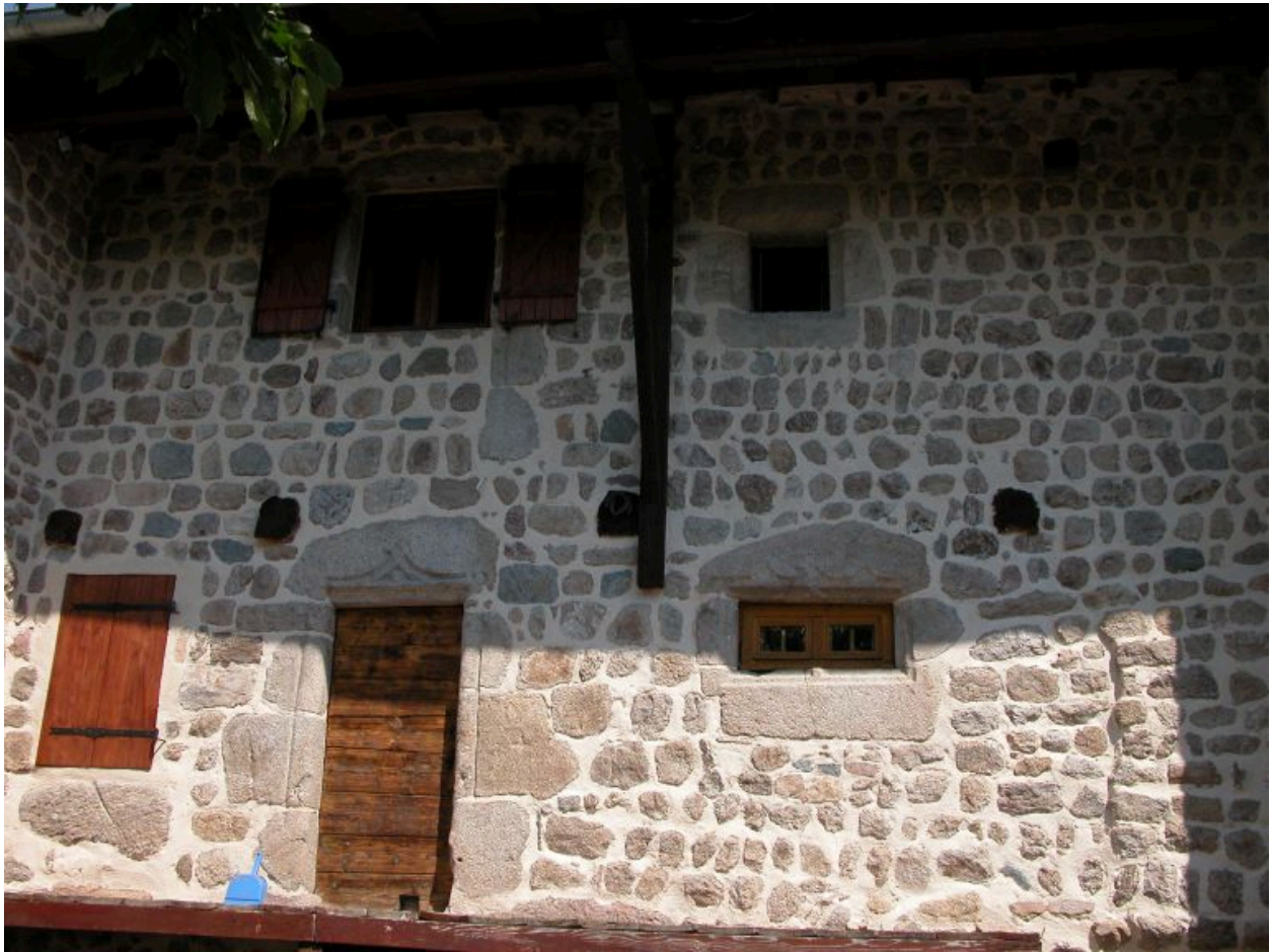
Détail des niveaux d'habitation du logis.
