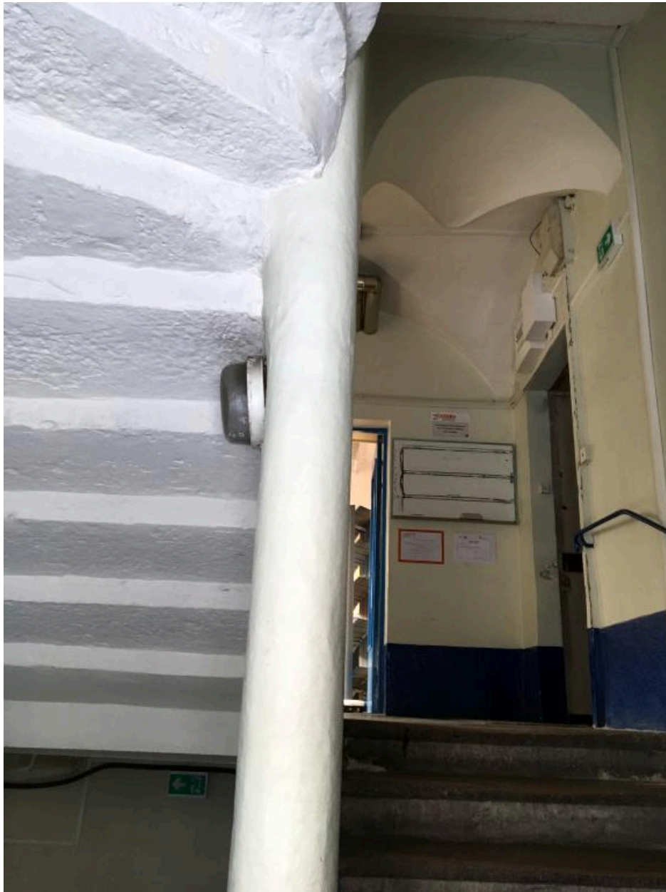
Corps de bâtiment sur quai Jean Moulin (pavillon d'angle) : escalier à mur noyau
