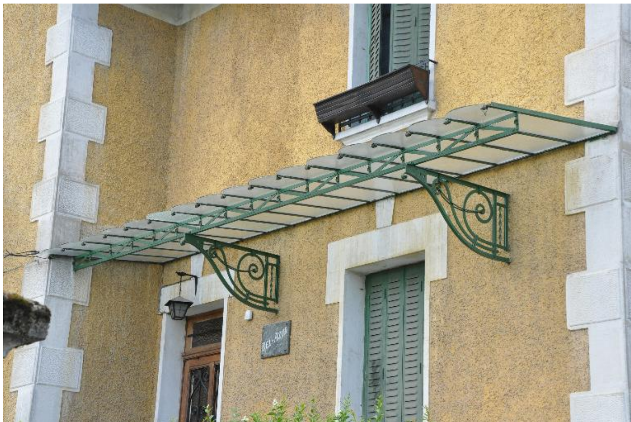
Détail de la marquise
