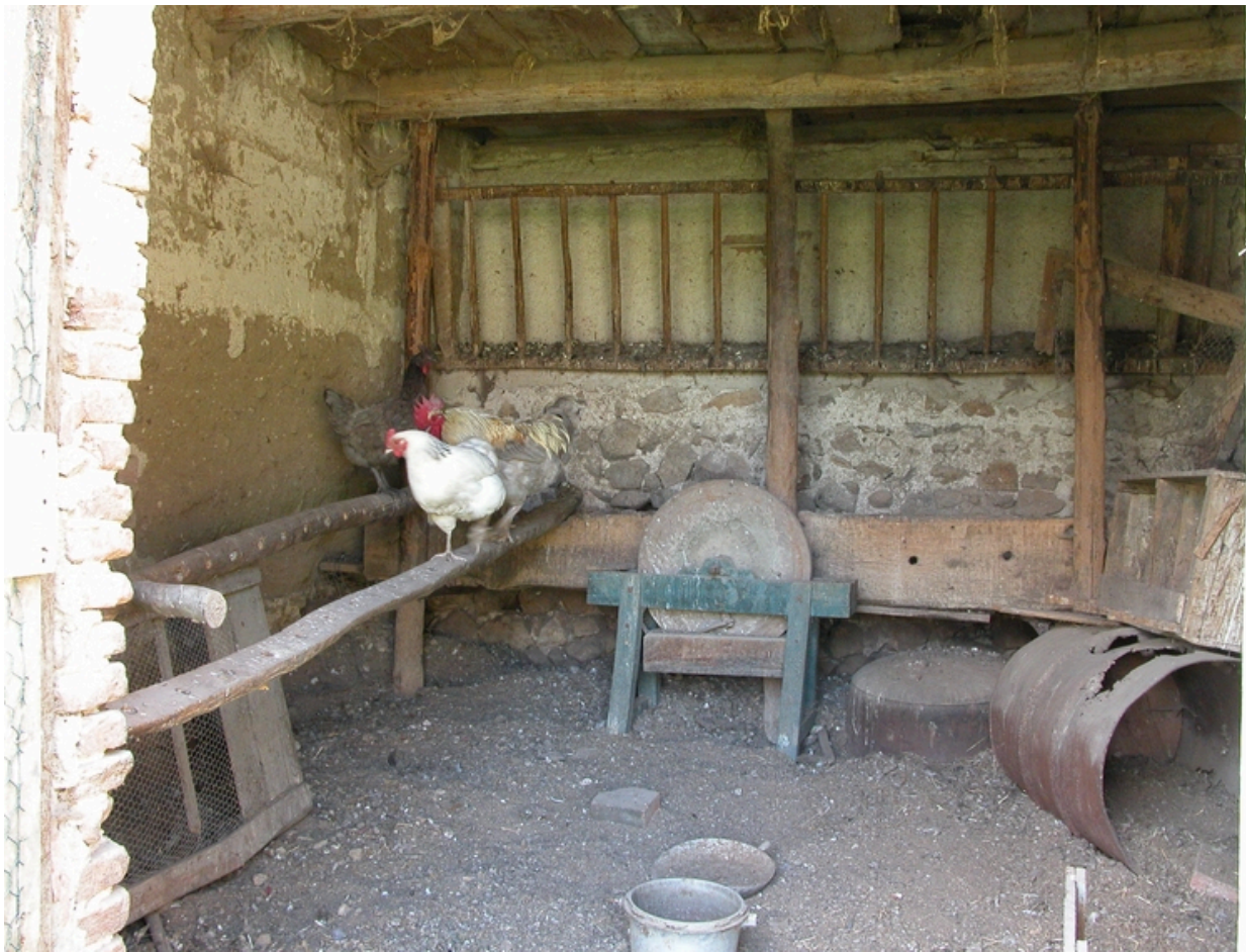
Vue intérieure de l'écurie.
