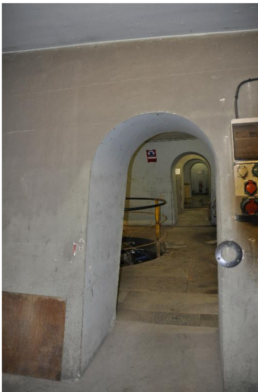
Vue des galeries communicantes entre les turbines des groupes verticaux
