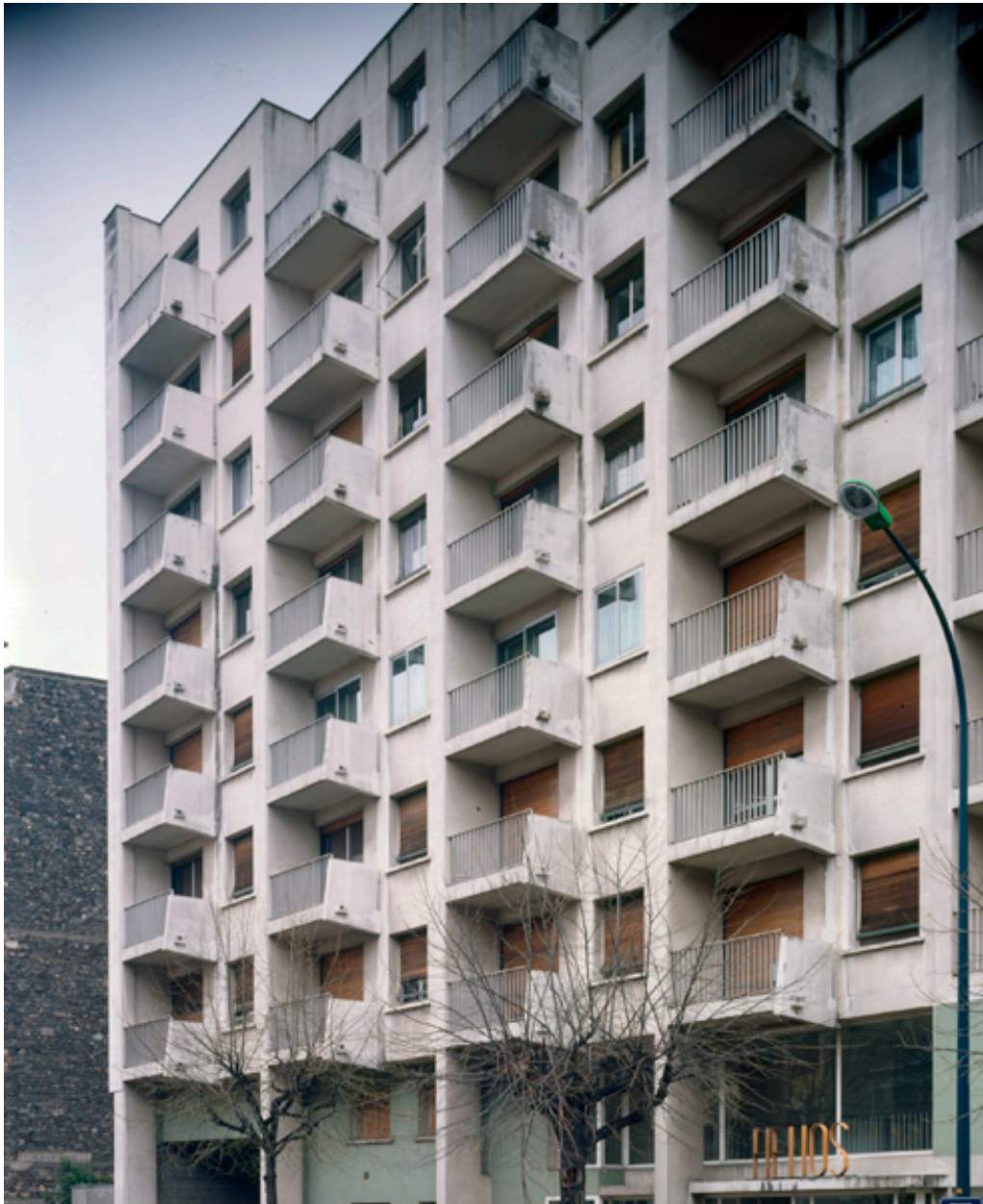
Détail de façade sur le boulevard Cote-Blatin
