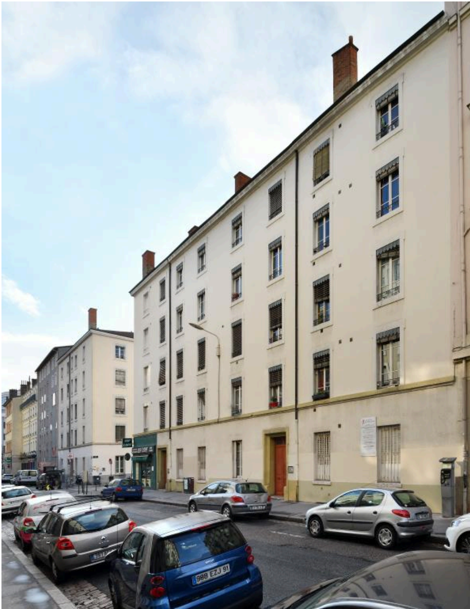
Vue d'ensemble de la cité, rue Reinach (vue prise du nord-ouest)
