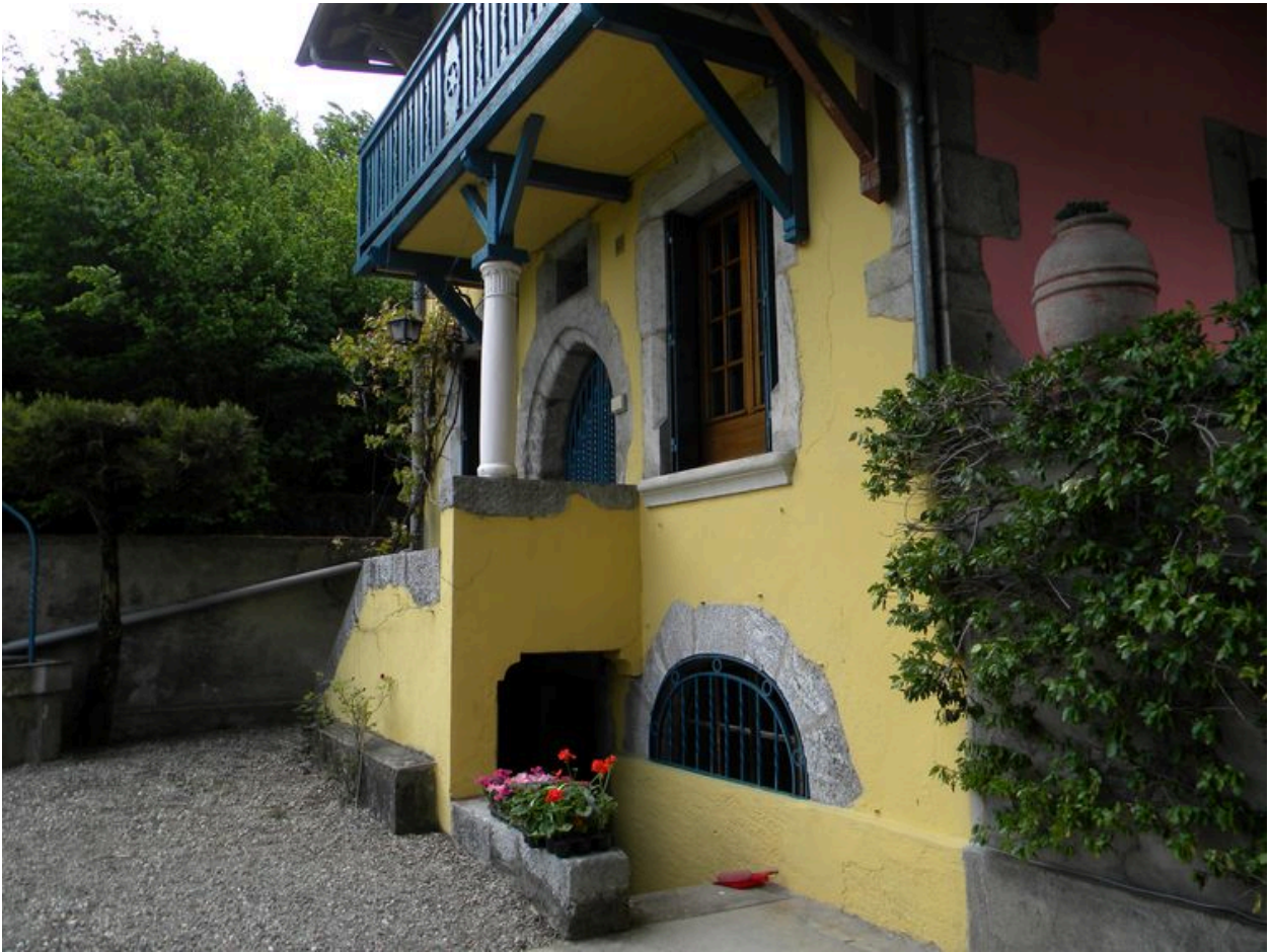
Détail du mur pignon sud.
