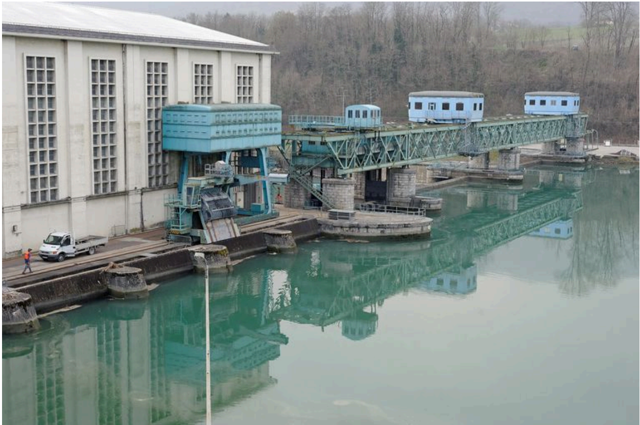
Vue de l'usine-barrage, face amont (nord), depuis la rive gauche
