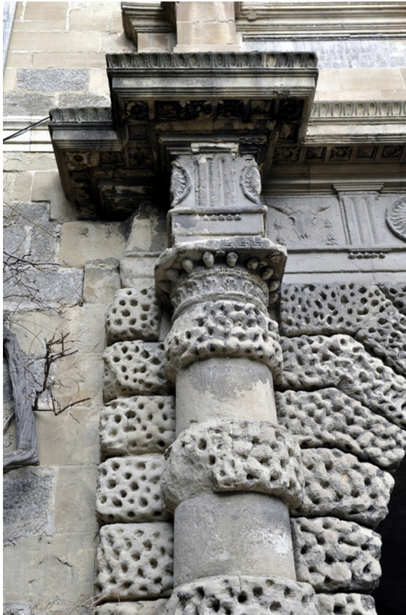
Détail d'une colonne engagée.
