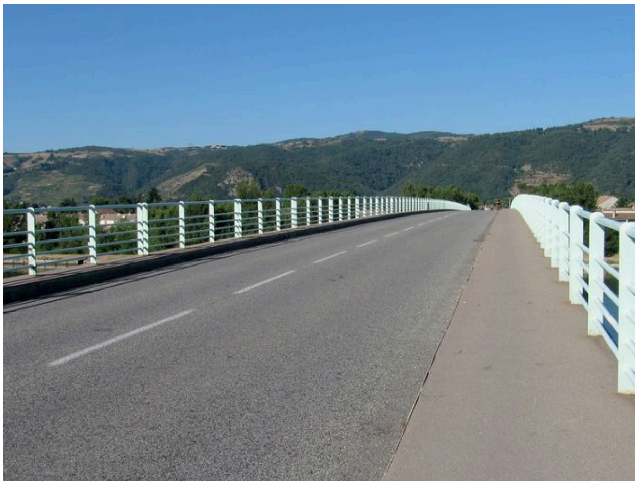
Chaussée du pont (depuis la rive gauche)
