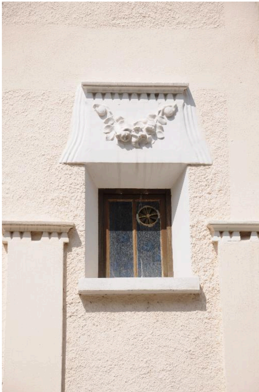
Détail sur un jour de l'escalier
