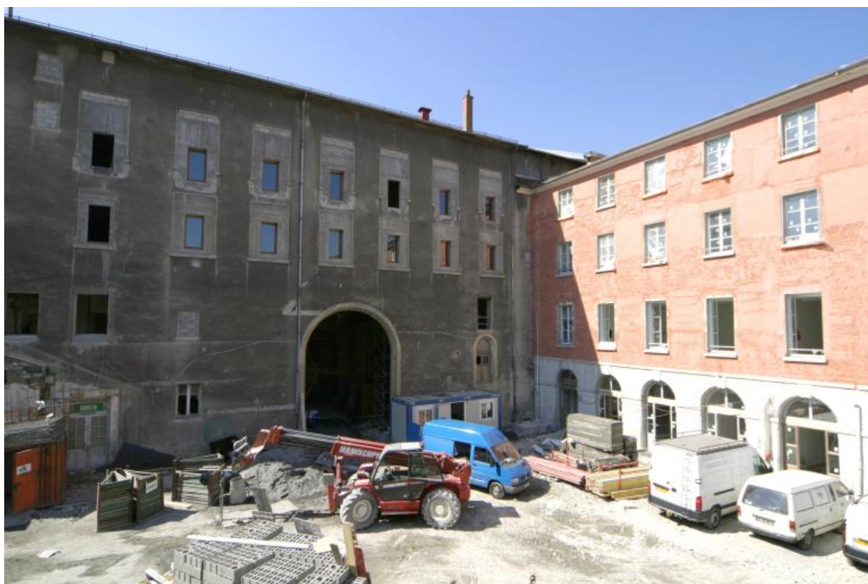
Travaux sur la chapelle (CDI) et l'aile 19e en 2004 (phot. Collectif ITEM)
