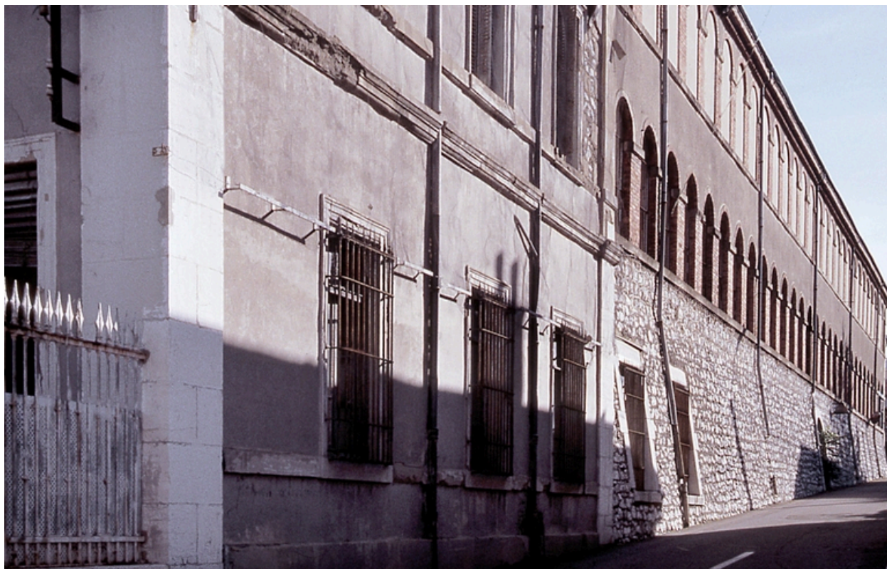
Vue ouest du chemin de Chony, façade sud
