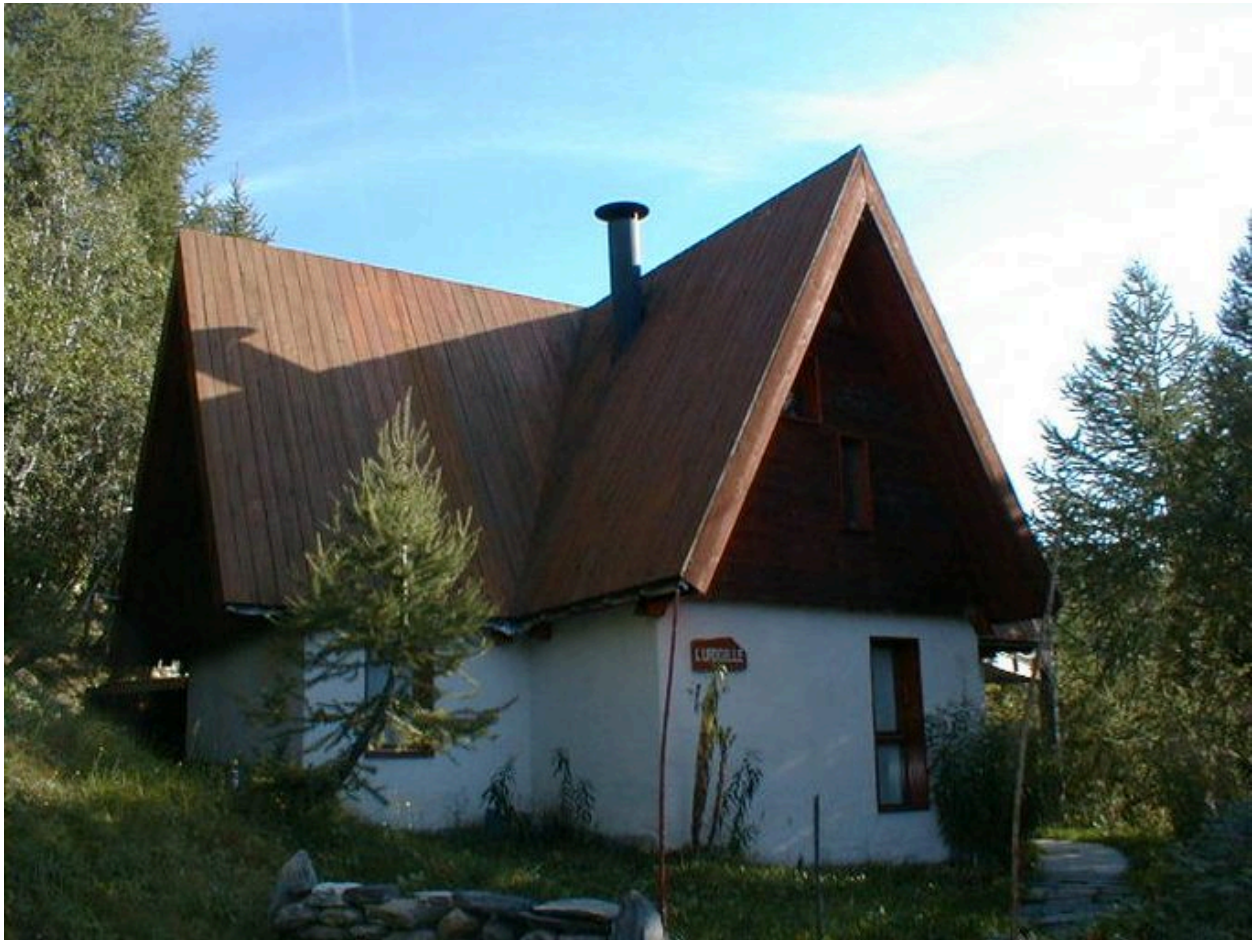
Chalet n° 16. Vue depuis le nord-ouest
