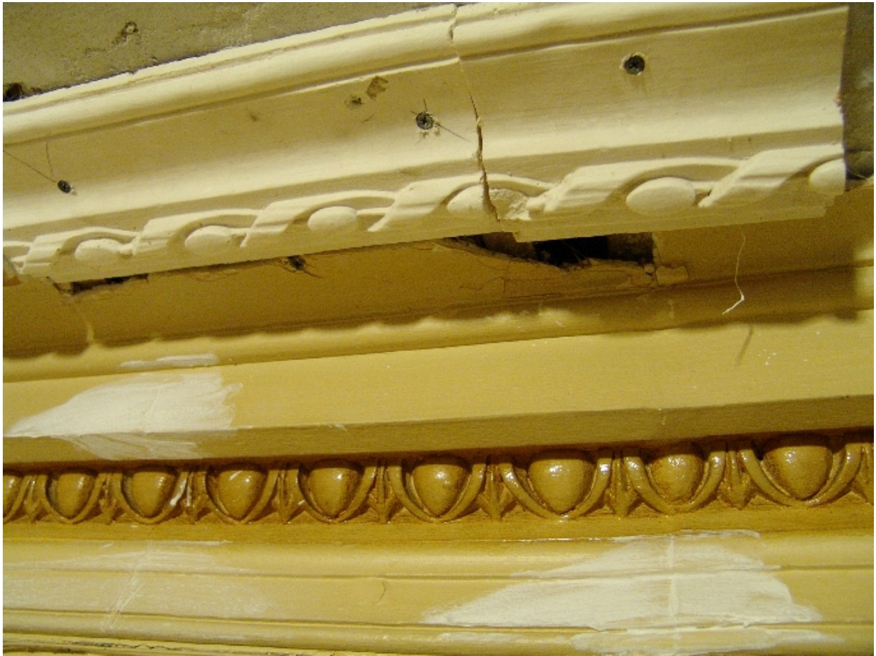
Hall : restauration du plafond
