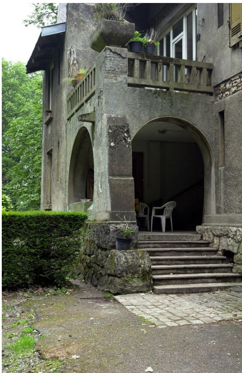
Façade principale, porche de gauche
