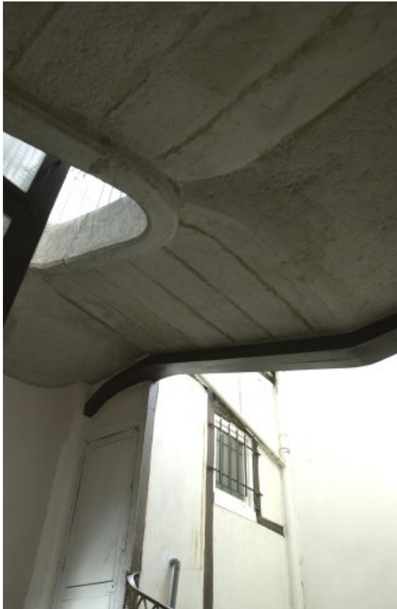
Escalier, vue du dessous des marches du cinquième étage
