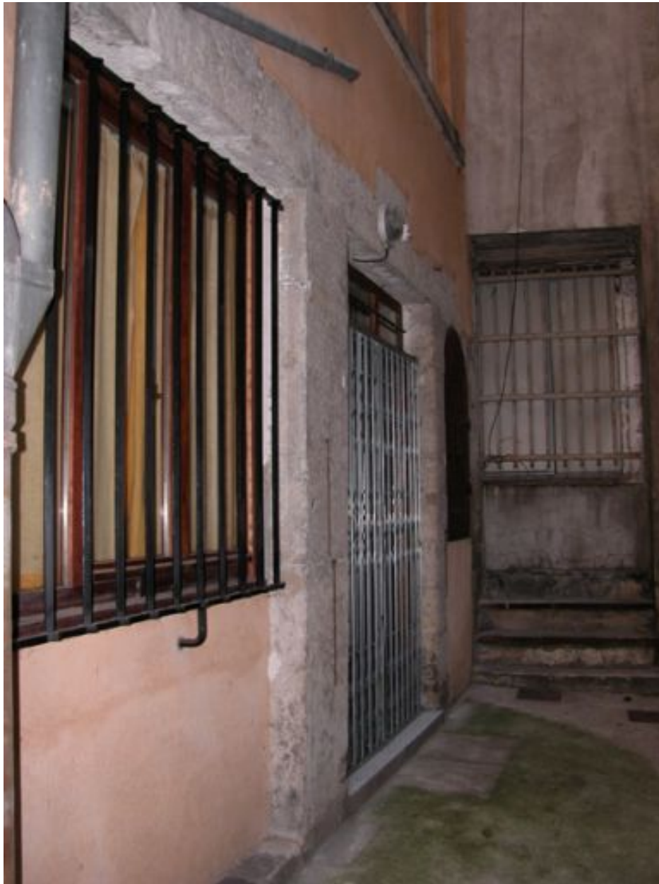
2e corps de bâtiment, élévation sur l'impasse, partie est, rez-de-chaussée
