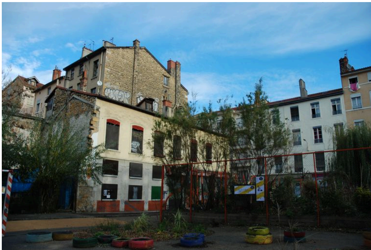
Vue générale, avant démolition (état novembre 2012)
