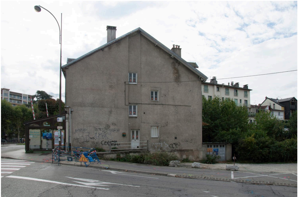
Élévation latérale, vue prise de l'ouest
