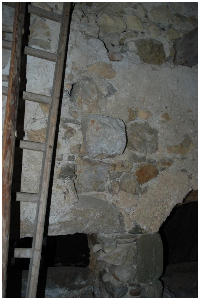
Détail d'un corbeau situé au-dessus des ouvertures de la première pièce.
