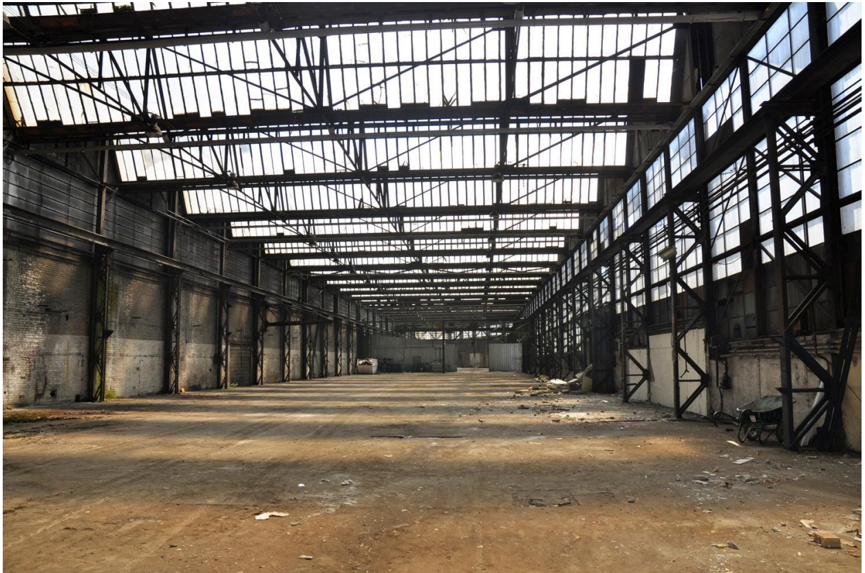
Halle démolie prévue pour accueillir le skate Park
