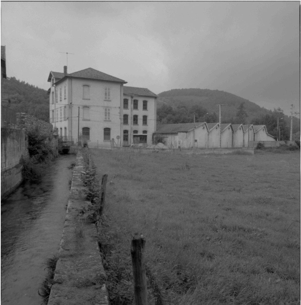
Vue partielle du bief alimentant les turbines de l'usine Giron.
