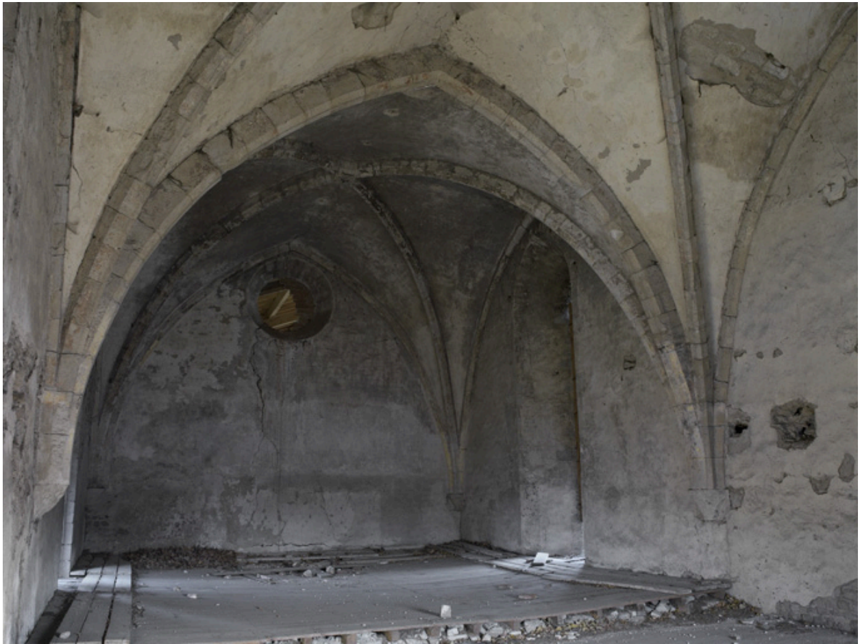
Vue d'ensemble des voûtes de la chapelle en direction du choeur (à l'est).
