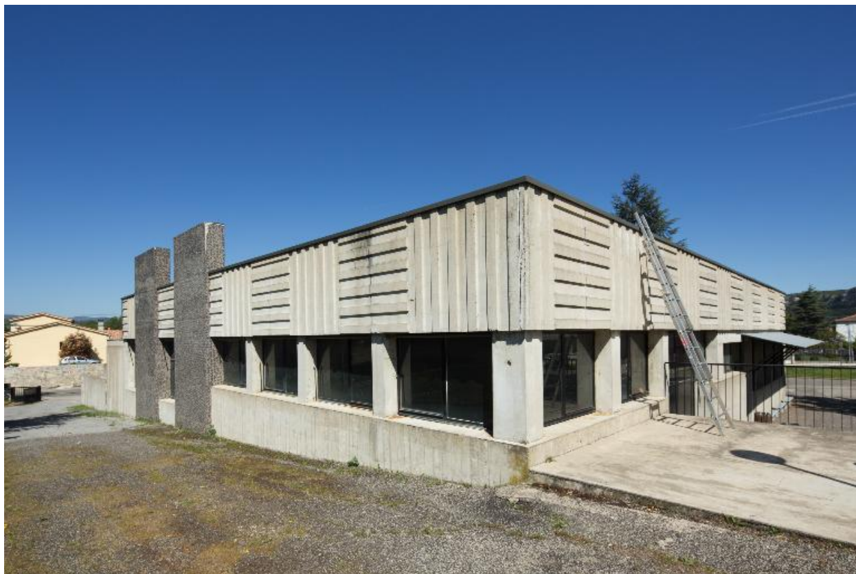
Ateliers : façades nord et ouest
