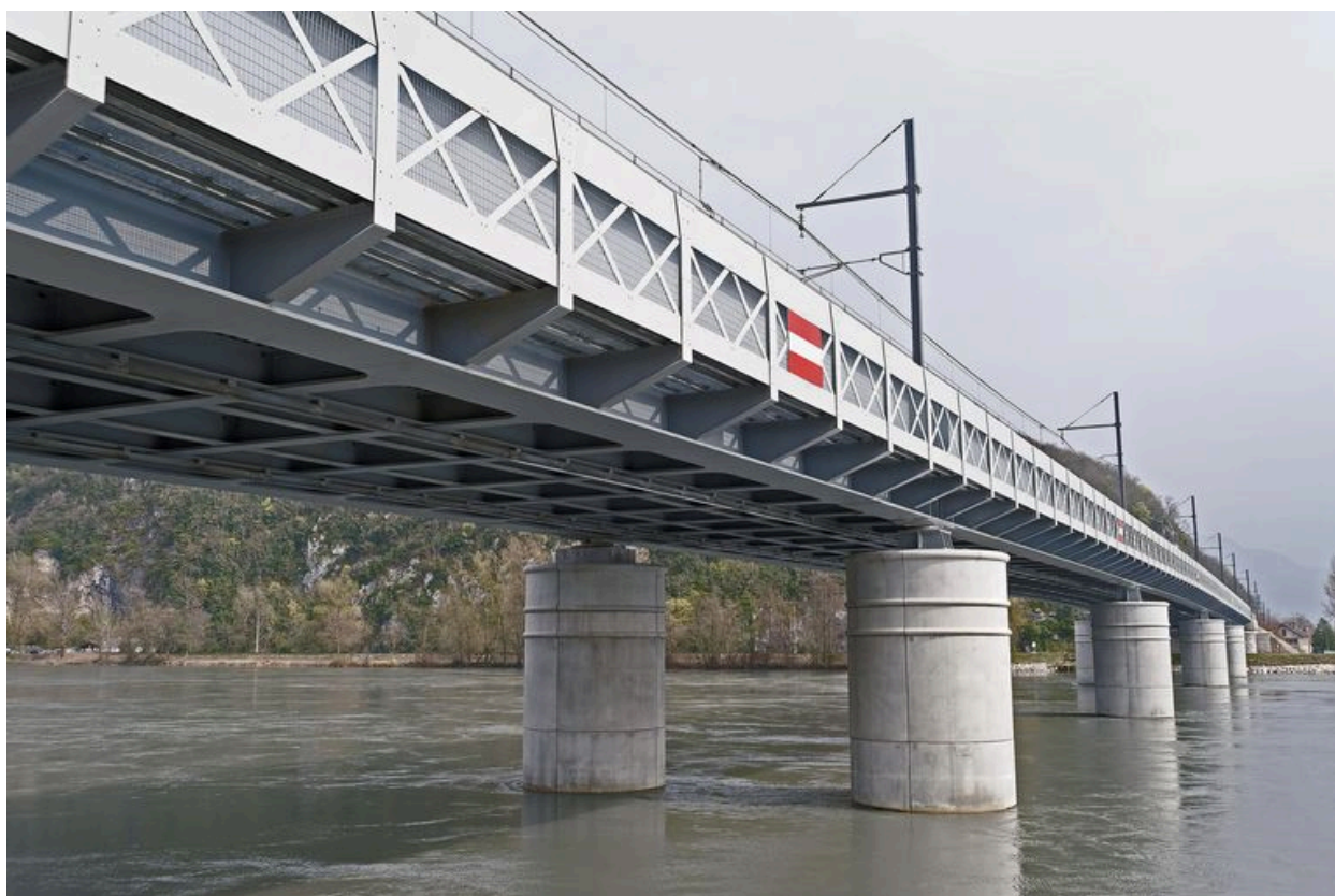
Vue de la face aval (depuis la rive droite)
