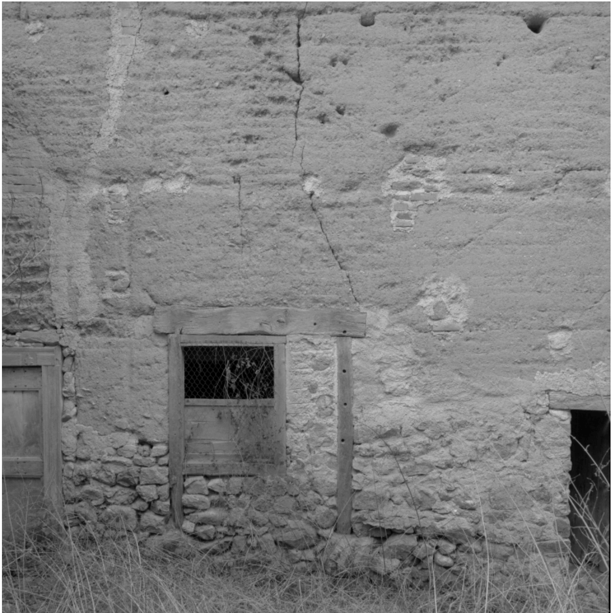
Détail de l'élévation postérieure sur la cour ouest : pisé du 16e siècle ?
