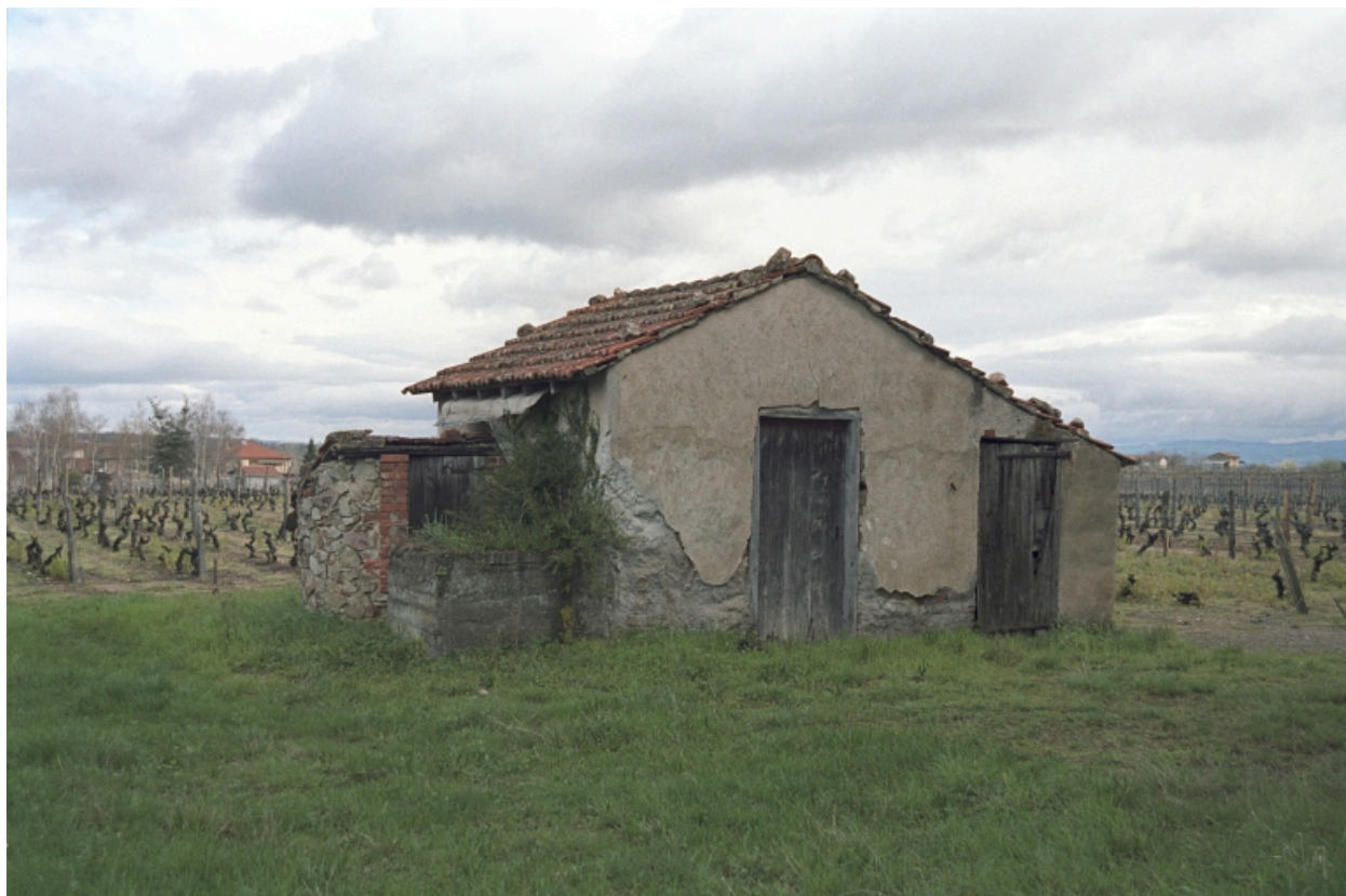
Sainte-Agathe-la-Bouteresse, Mollian (1985 C1 95). Loge en rez-de-chaussée de type R1a1. Vue d'ensemble.
