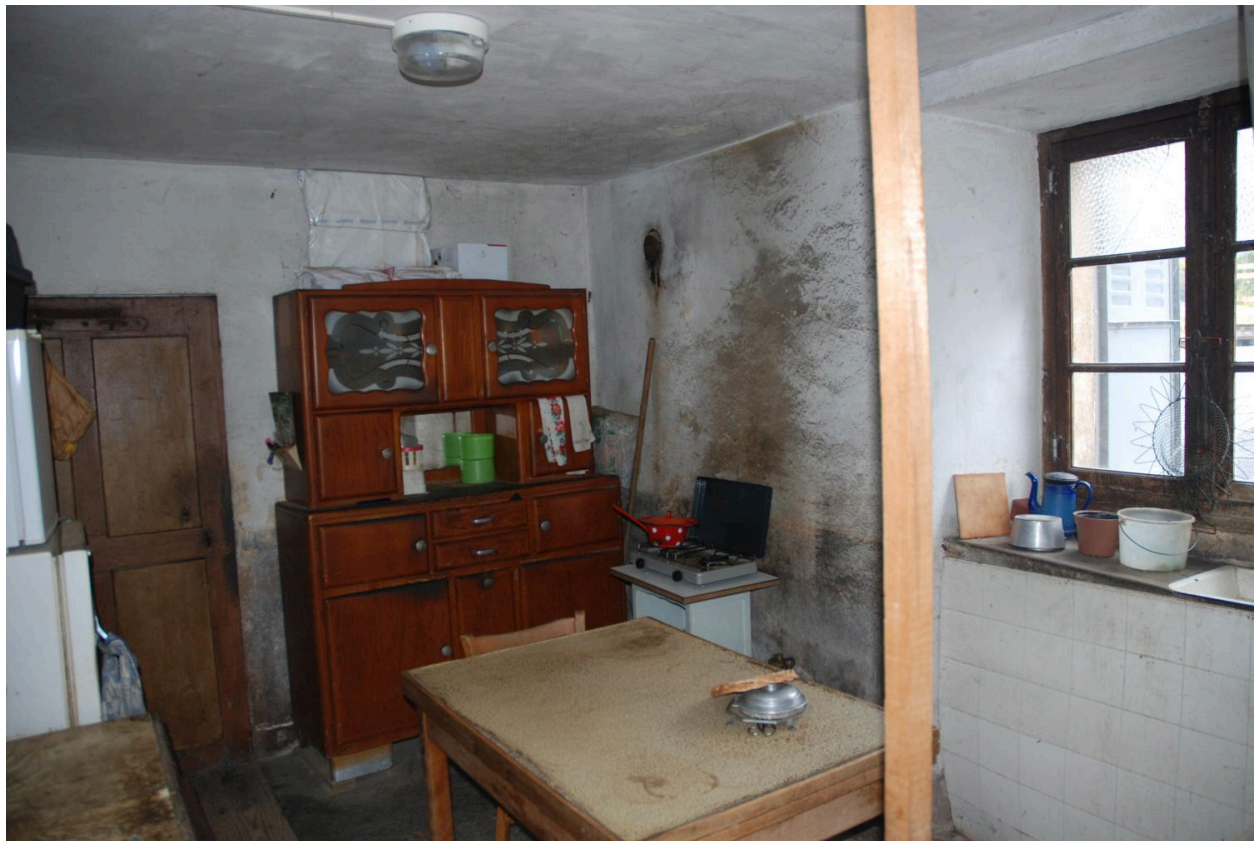
Cellier viticole, dit sarto (2018 E3 1008). Vue intérieure de la cuisine.
