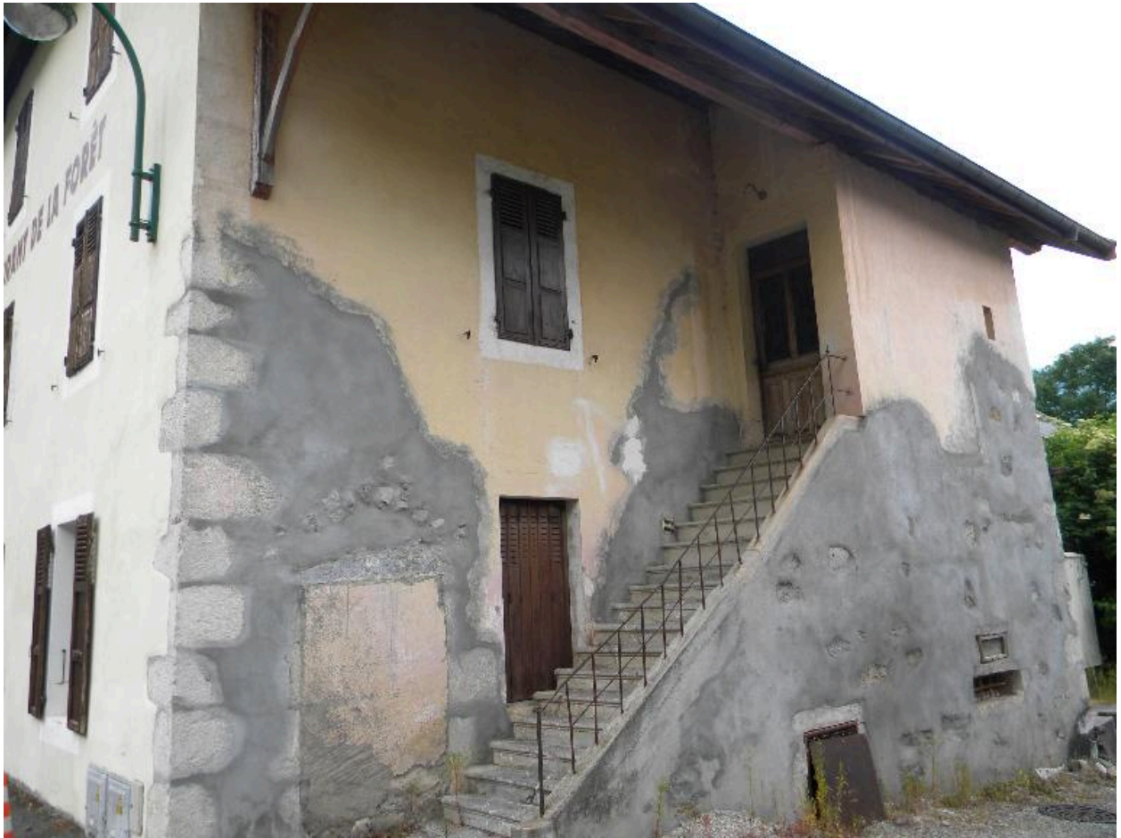
Vue de trois-quarts sud-ouest d'une ancienne auberge (2008 B3 562 bâtiment 3)
