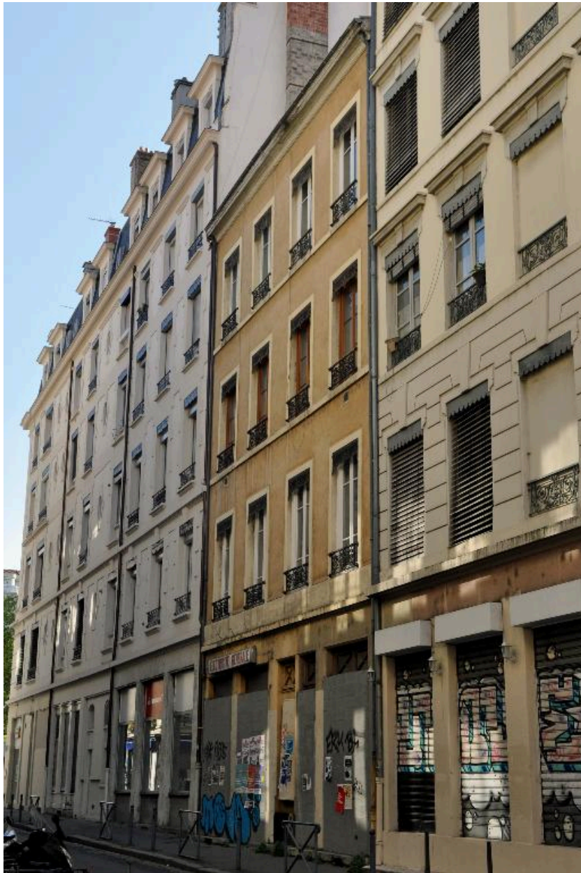
Immeuble ouest donnant sur la rue d'Anvers, élévation sur rue
