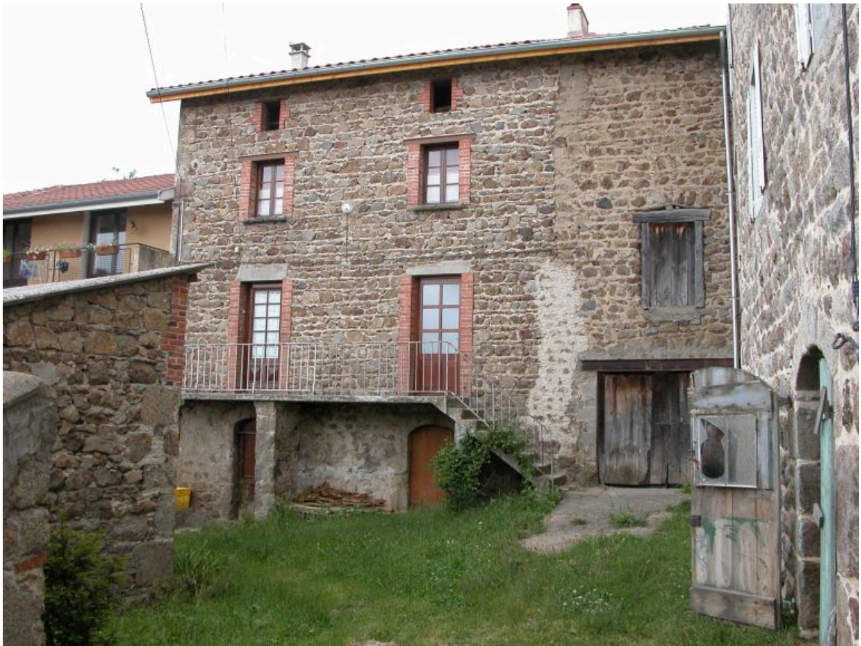
Ancienne grange-étable (1987 AC 389) de la ferme avant division de celle-ci.
