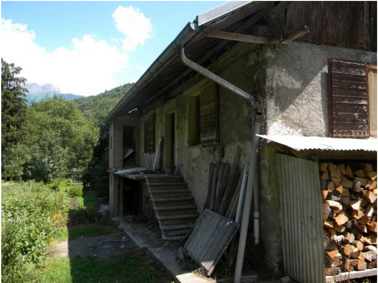
Vue de la façade nord.
