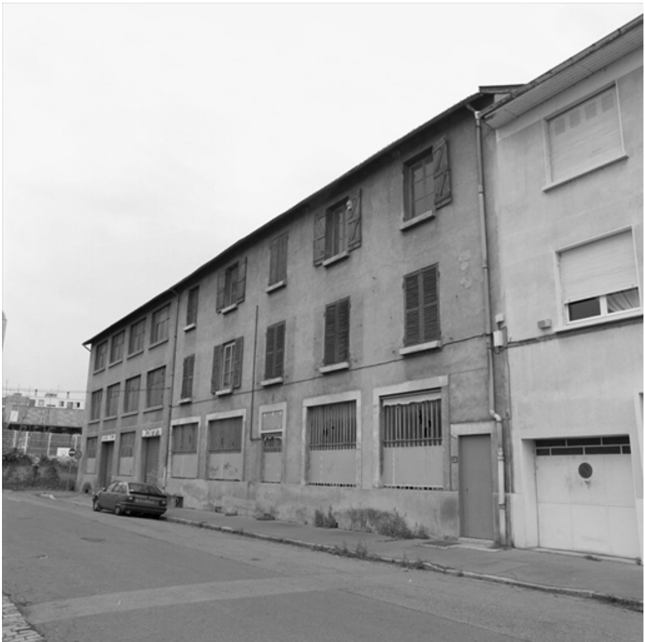
Vue générale est
