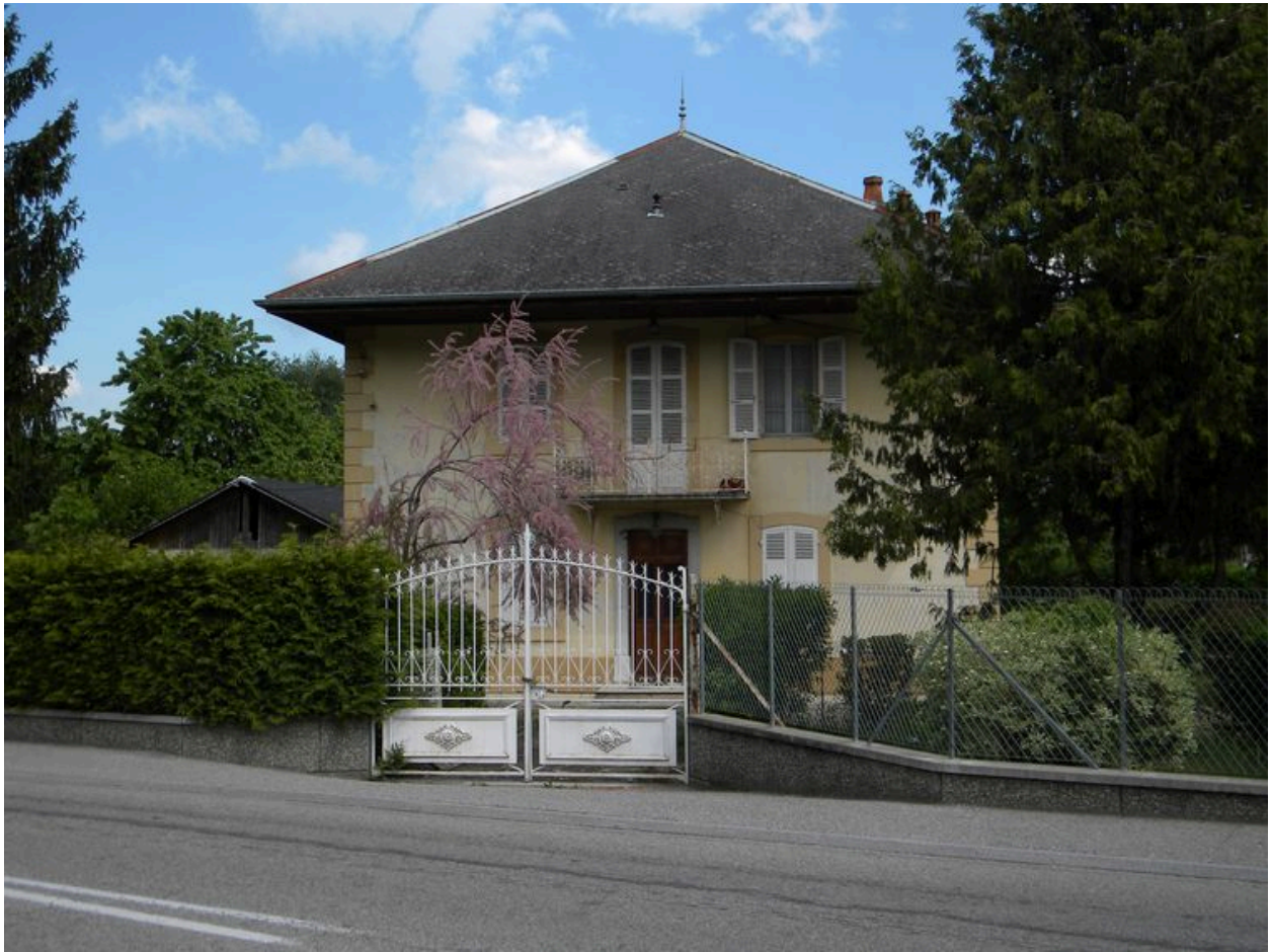
Vue de la façade principale derrière son petit parc arboré.
