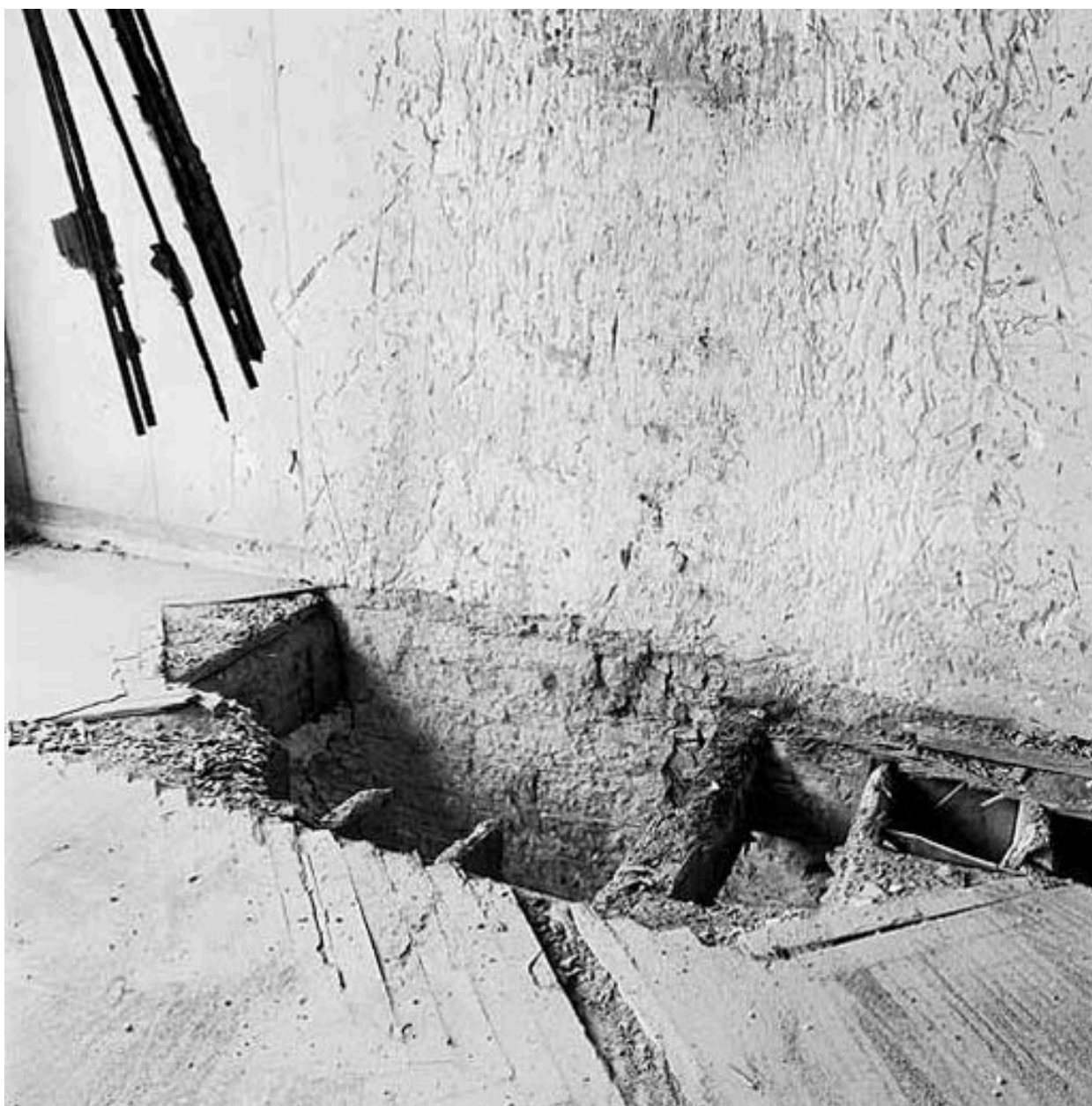
Corps sur la rue du Bât-d'Argent, détail de la structure du plancher vue depuis le sol du 2e étage
