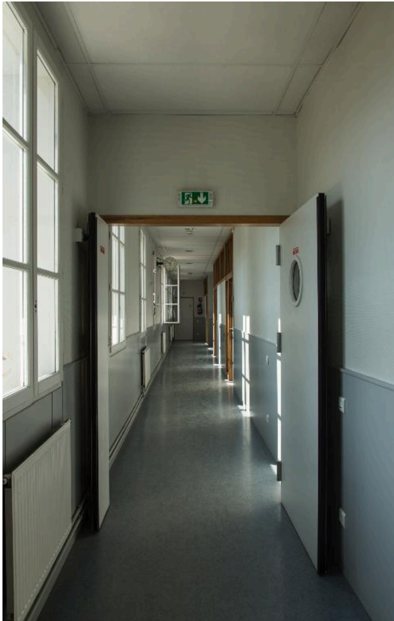
Bât. A : couloir au premier étage de l'aile est
