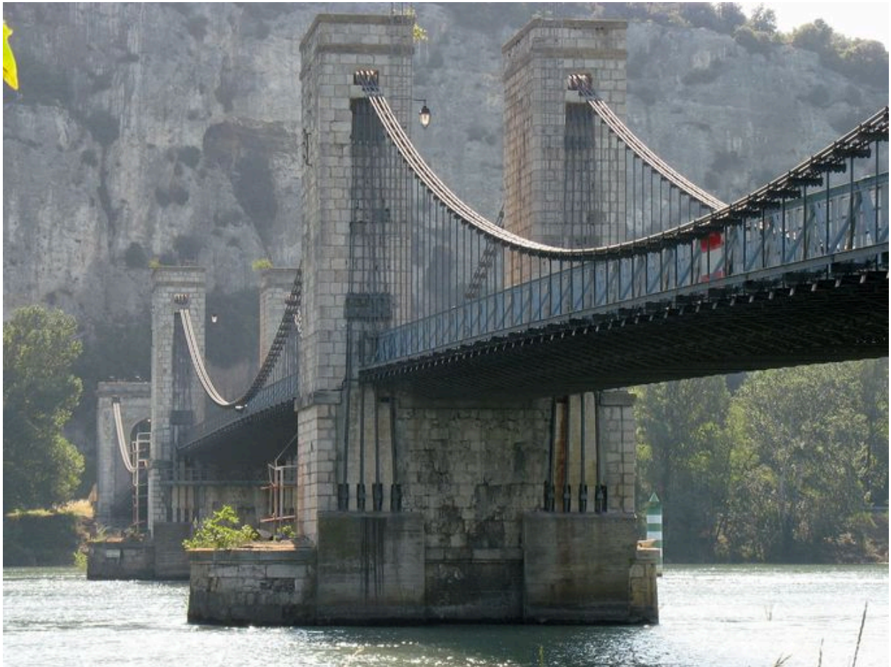
Vue partielle, côté amont (depuis la rive droite)
