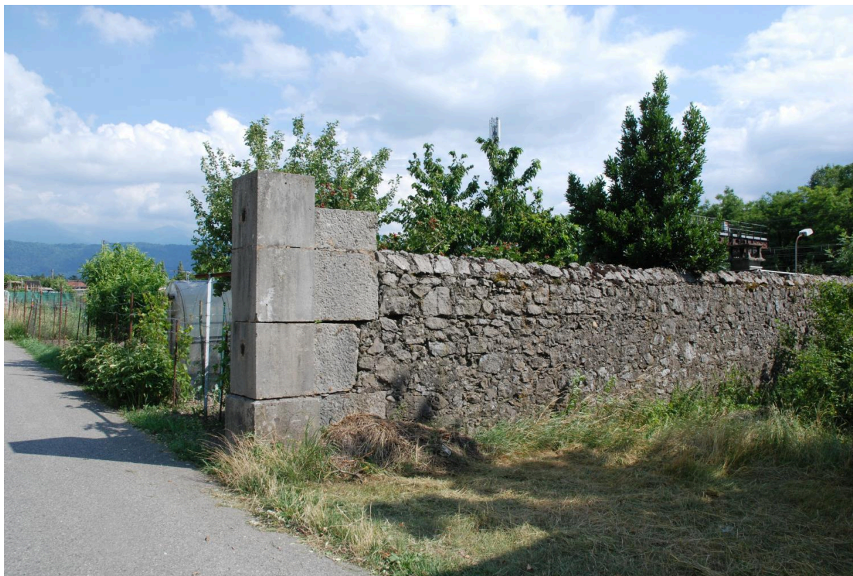
Mur du clos avec pilier en pierre de taille.
