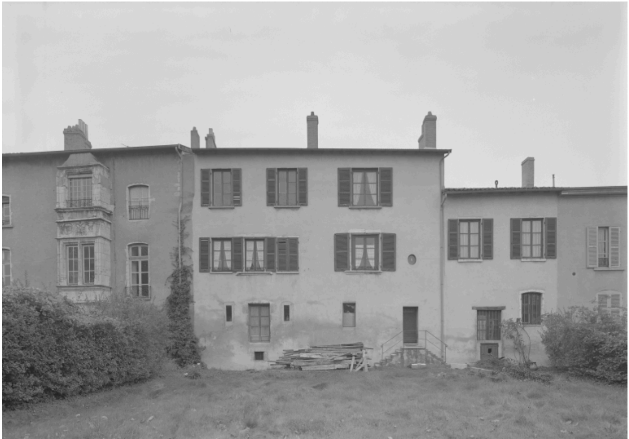
Elévation sur jardin (à droite, maison n°29 rue du Gouvernement, à gauche, maison basse des Sires de Villars, séparée par une venelle latrinale).
