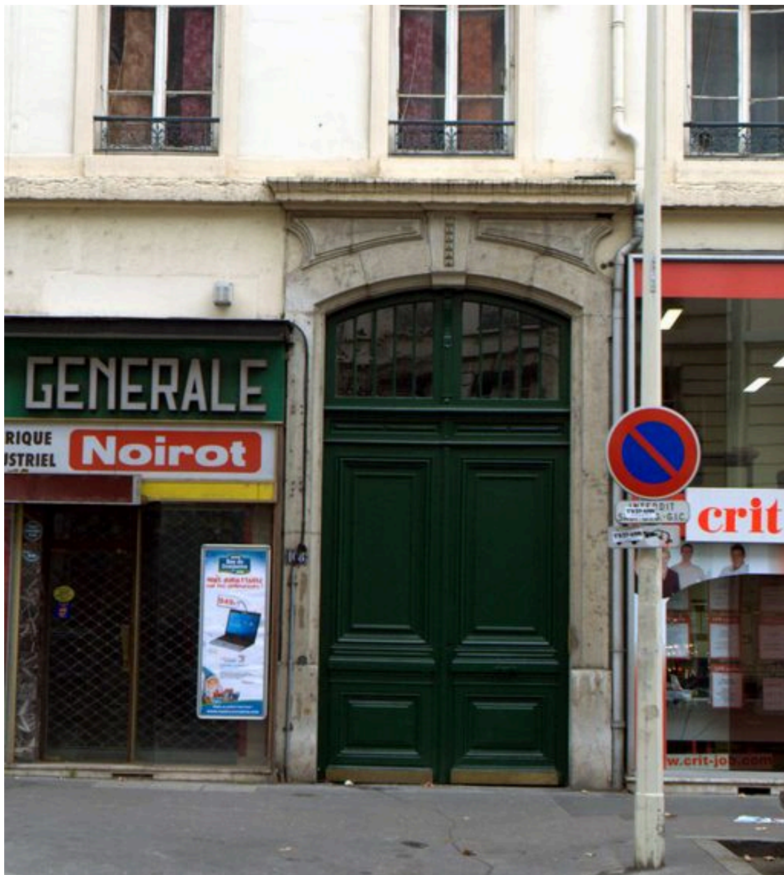
Détail de la porte d'entrée
