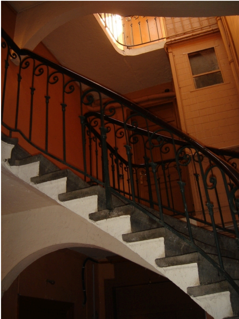
Escalier à double jour
